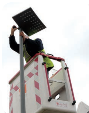
3. Pose du luminaire à LED (50 watts de conso)
