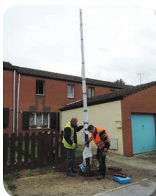
2. Installation d'un nouveau candélabre
