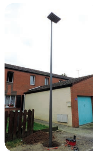
5. Le candélabre est en service. Il ne reste plus que les finitions autour de la base.
