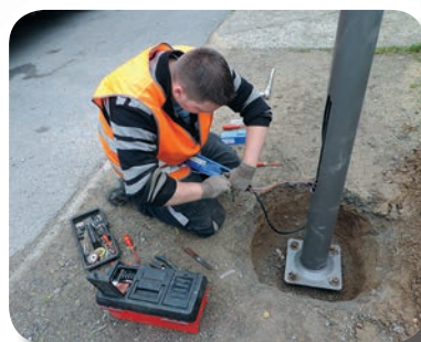
4. Raccordement au réseau d'éclairage public
