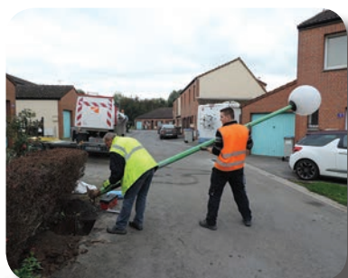
1. Démontage d'un vieux candélabre
