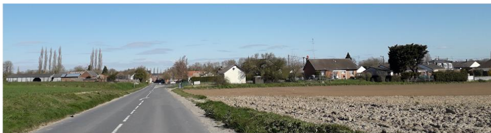
3 – L'arrivée par le sud, en passant par le quartier de la sucrerie et le pont de l'ancien chemin de fer. Là encore, les peupliers en bordure de village se remarquent clairement.
